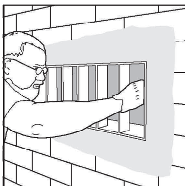
清理孔洞中的溢出物。
